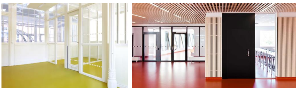
Esempi di applicazione di pavimento continuo in gomma in edifici scolastici. (1) e (2). Dettaglio di posa di zoccolino in continuità con il pavimento (2)
